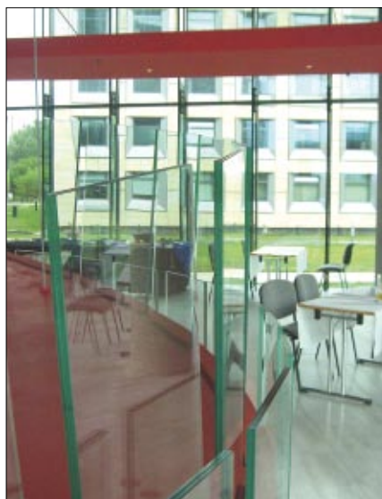
Fot. 8. Balustrady pochylni ze szkła laminowanego
