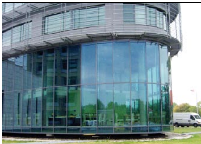
Fot. 1. Podcięty cokół nadający budynkowi wizualnej lekkości
