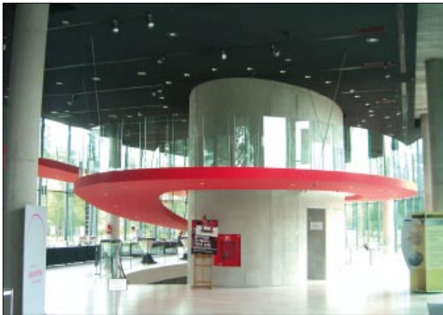
Fot. 7. Charakterystyczny element wnętrza – podwieszona pochylnia ze szklanymi balustradami
