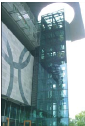
Fot. 2. Przeszkłony sztyw windowy wysunięty przed lico ściany zachodniej
