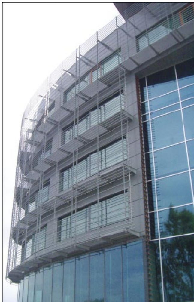
Fot. 5. Ażurowa powłoka z pomostami technologicznymi i elementami ochrony przeciwsłonecznej
